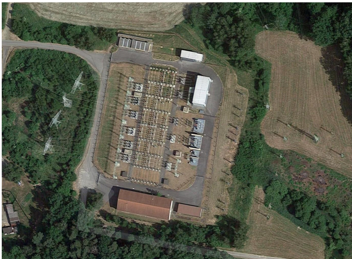
Obr. č. 32 – Fotografie 110kV rozvodny Noviny Pod Ralskem
