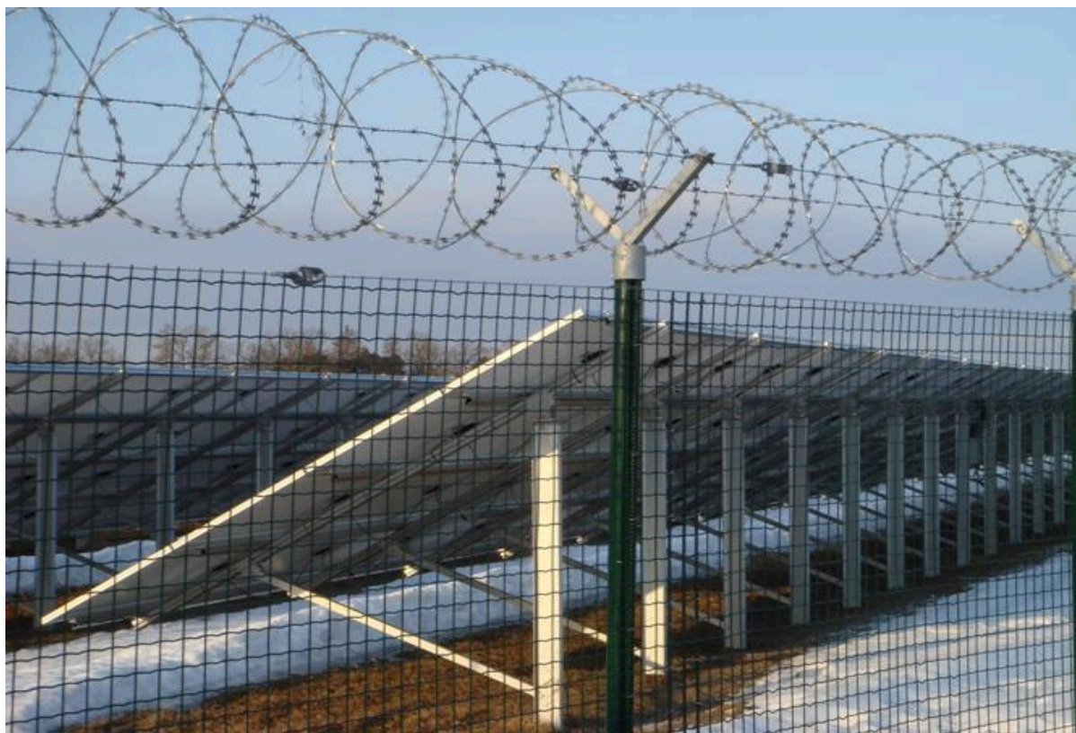
Obr. č. 13 – Zabezpečení elektrárny oplocením s žiletkovým drátem
